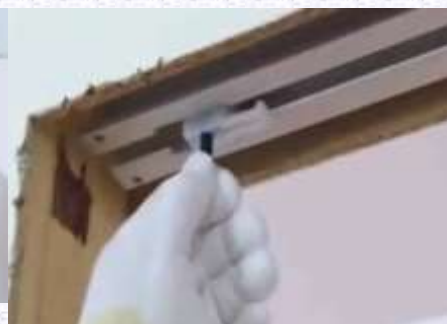
15. Installare lo STOP FINALE all'interno del binario.
