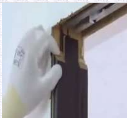
16 Fissare il telaio di battuta
