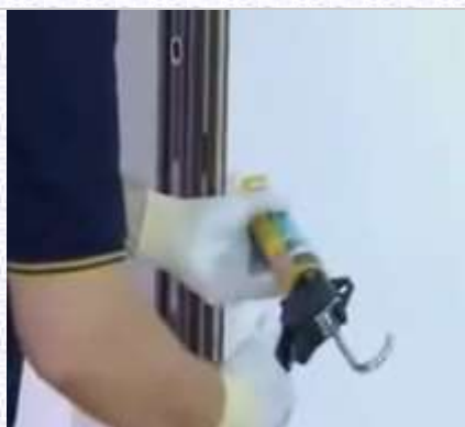
19. Applicare il silicone per un corretto montaggio senza chiodini.
