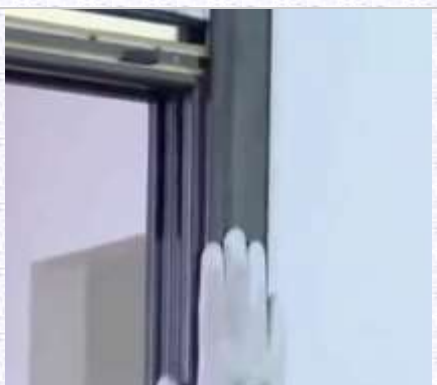
20. Fissare il coprifilo con del silicone .
