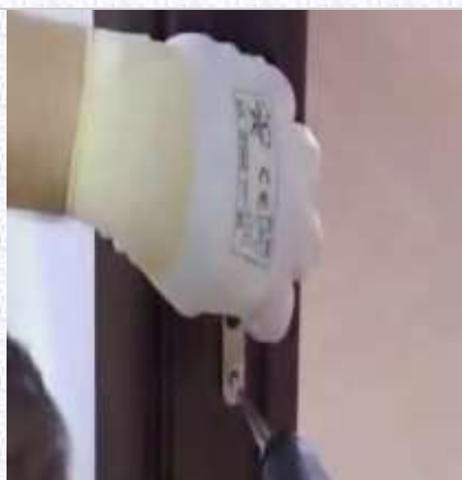
22 Dopo aver stabilito l'altezza della contropiastra, avvitarela nel telaio.
